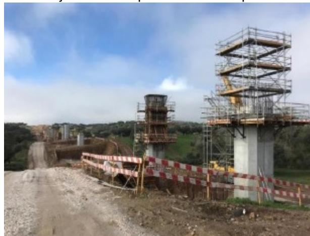
Obras em execução – Dezembro 2020
