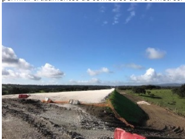
Obras em execução – Dezembro 2020
